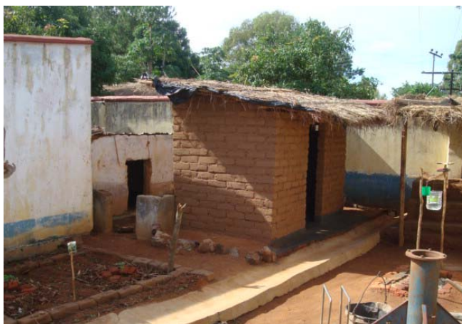
Latrine Ecosan avec, à l'avant, le futur potager et en face le système de lavage des mains.
