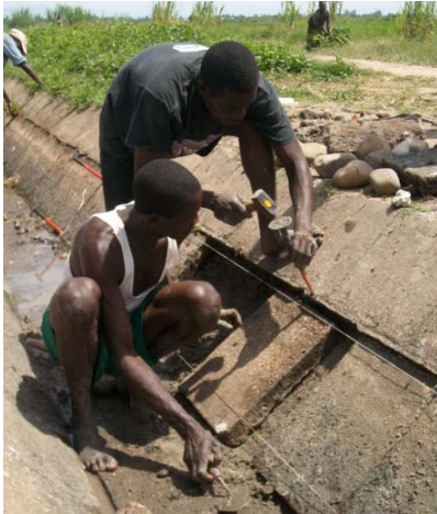
Travaux d'assainissementsur le site de déplacés
