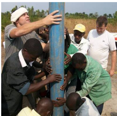
Mise en place du pré-tubage
