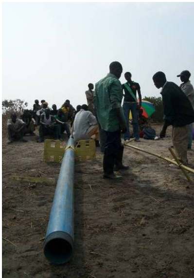
Préparation du chantier
