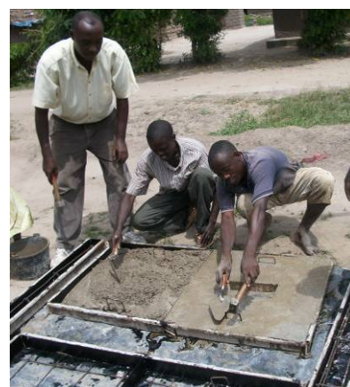
Moulage de dalle de latrines
