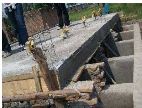
Construction des latrines
