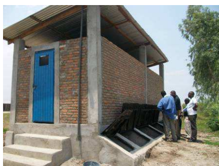
Latrines achevées avec accès aux fosses par l'arrière
