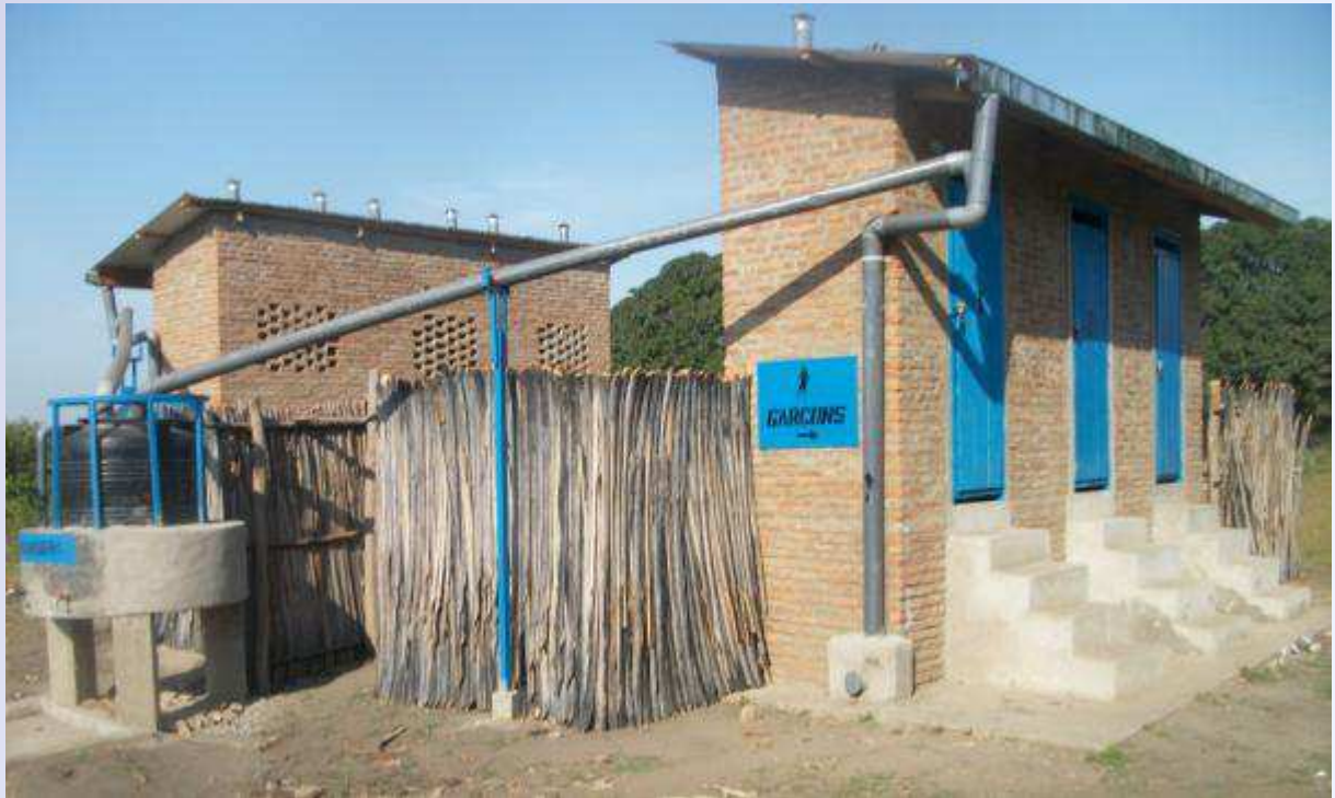
Latrines de l'école primaire 2 sur Maramvya
